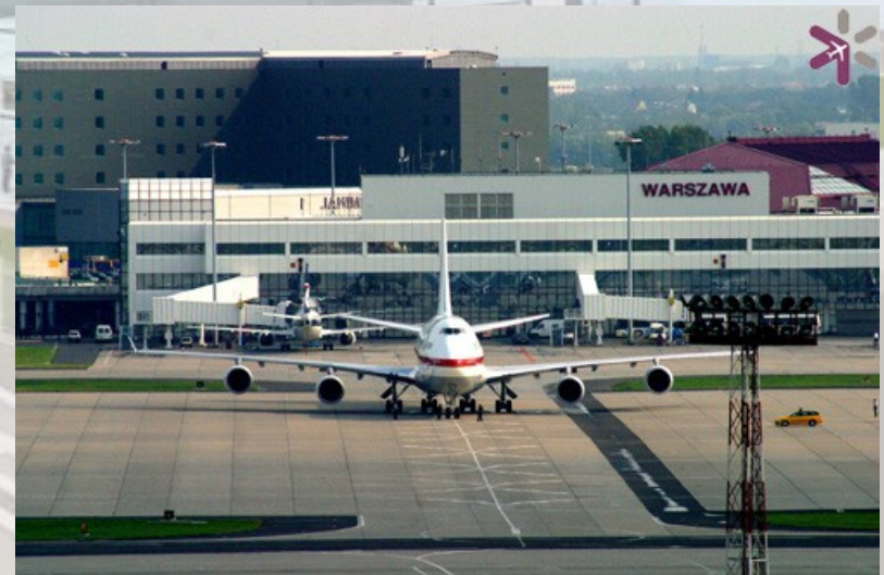
Lotnisko Okęcie Terminal I oraz II
